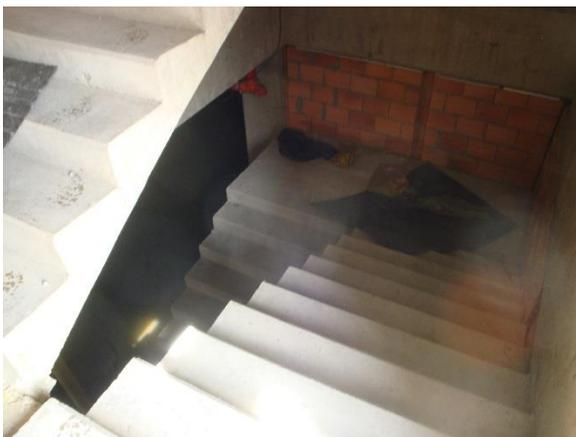
Las escaleras interiores se encuentran terminadas y fundidas sobre el costado oriental y las del costado occidental solo queda la del acceso a cubierta por terminar.
