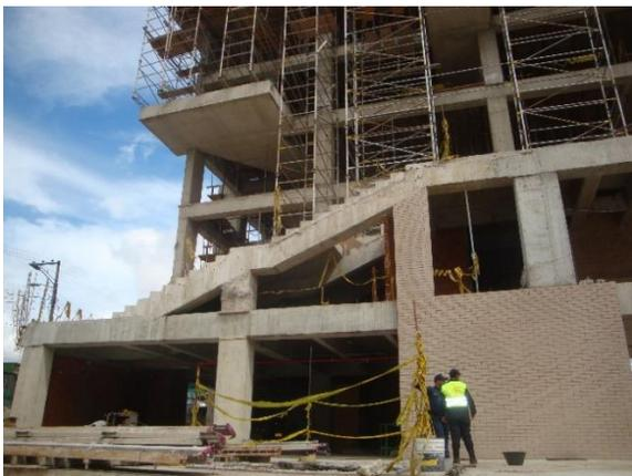
Se observa el inicio de la construcción de mampostería en ladrillo prensado para las caras exteriores en primeros pisos.
