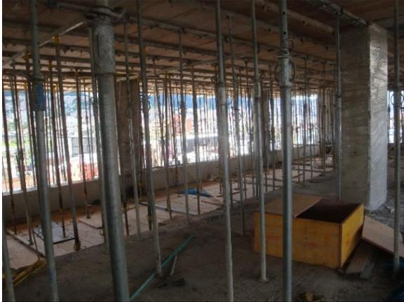
En el nivel de la cubierta falta un tramo para terminar la placa de entrepiso, se evidencian las formaleas temporales para sostener, las camillas y los pares armados en secciones para ajustar la altura deseada.
