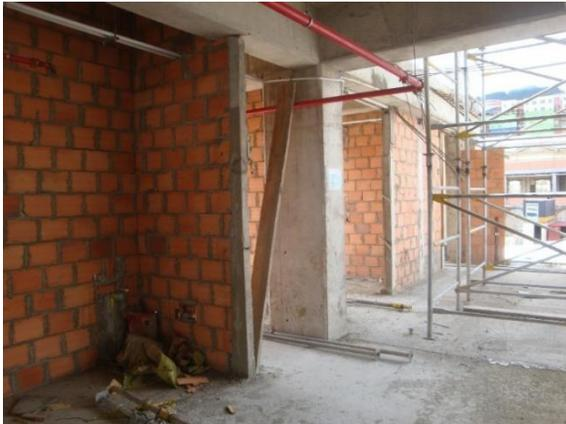
Se encuentran muros divisorios y muros a la vista con mampostería en bloque hueco de uso interno y no estructural unidos por juntas de mortero.
