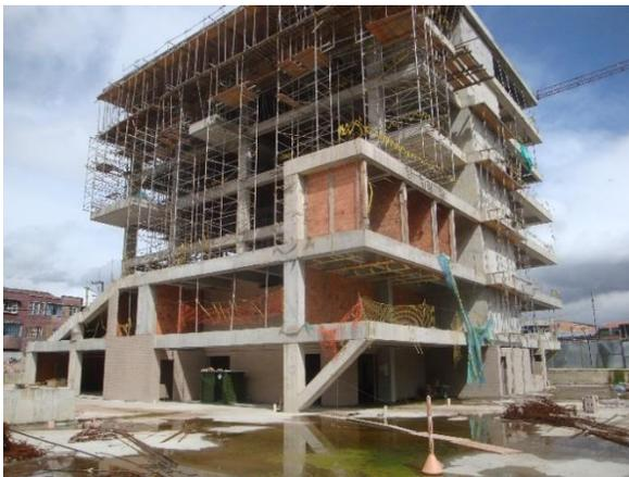
Armado y fundida de la estructura con columnas en concreto para soportar las cargas y esfuerzos de la edificación hasta el nivel de cubierta.
