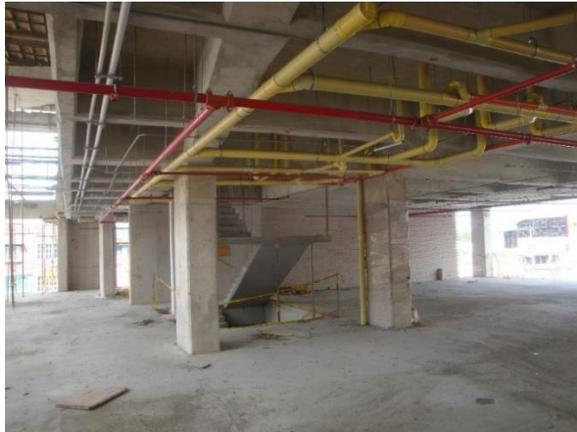
A lo largo de todos los pisos se observan instalaciones suspendidas y en mampostería de las redes de tuberías hidrosanitarias de agua potable y residuales.
