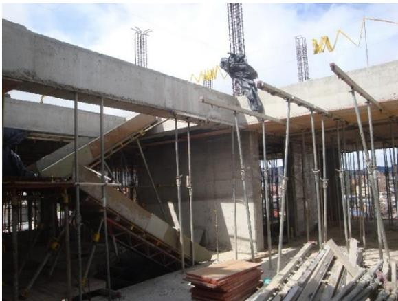
Las escaleras para el acceso a cubierta se encuentran con el encofrado y listo para vaciar y moldear el hormigón para la construcción de esta.
