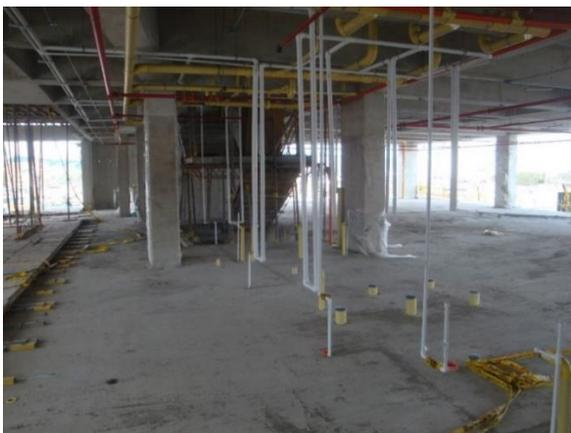
Instalación de redes de suministro de agua potable para facilitar la captación de agua.
