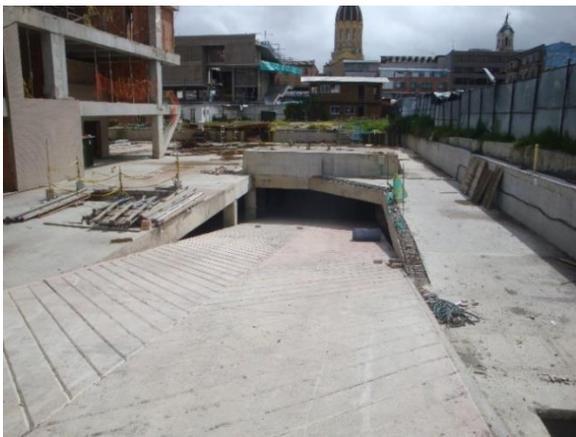
Rampa vehicular estriada armada y fundida queda pendiente por demoler una parte de placa antigua para dar el nivel indicado.
